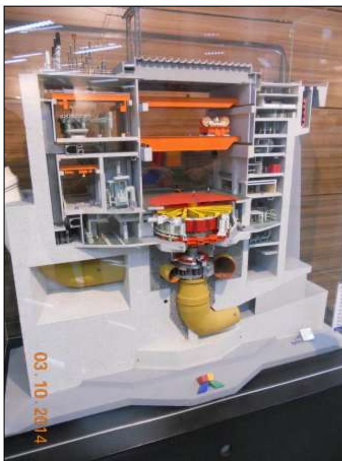
Figura 5 - Maquete da Estrutura de uma Turbina da Usina Hidrelétrica de Itaipu. FONTE: Frizanco (2014).
