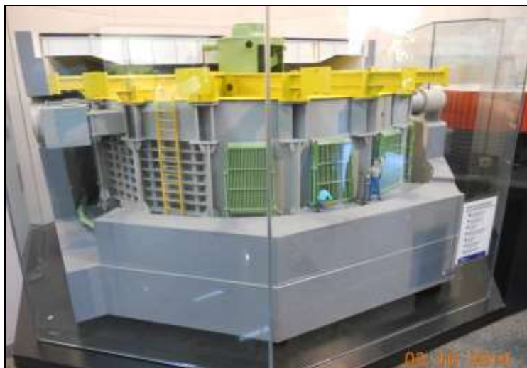
Figura 4 - Maquetes da Estrutura de Turbinas da Usina Hidrelétrica de Itaipu. FONTE: Frizanco (2014).
