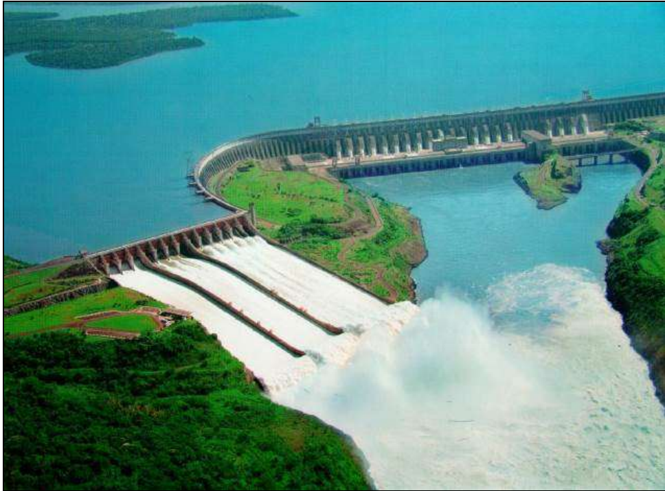
Figura 8 - Visão panorâmica da USINA HIDRELÉTRICA DE ITAIPU. FONTE: Foto Adquirida no Mirante da Usina Hidrelétrica de Itaipu (2014).
