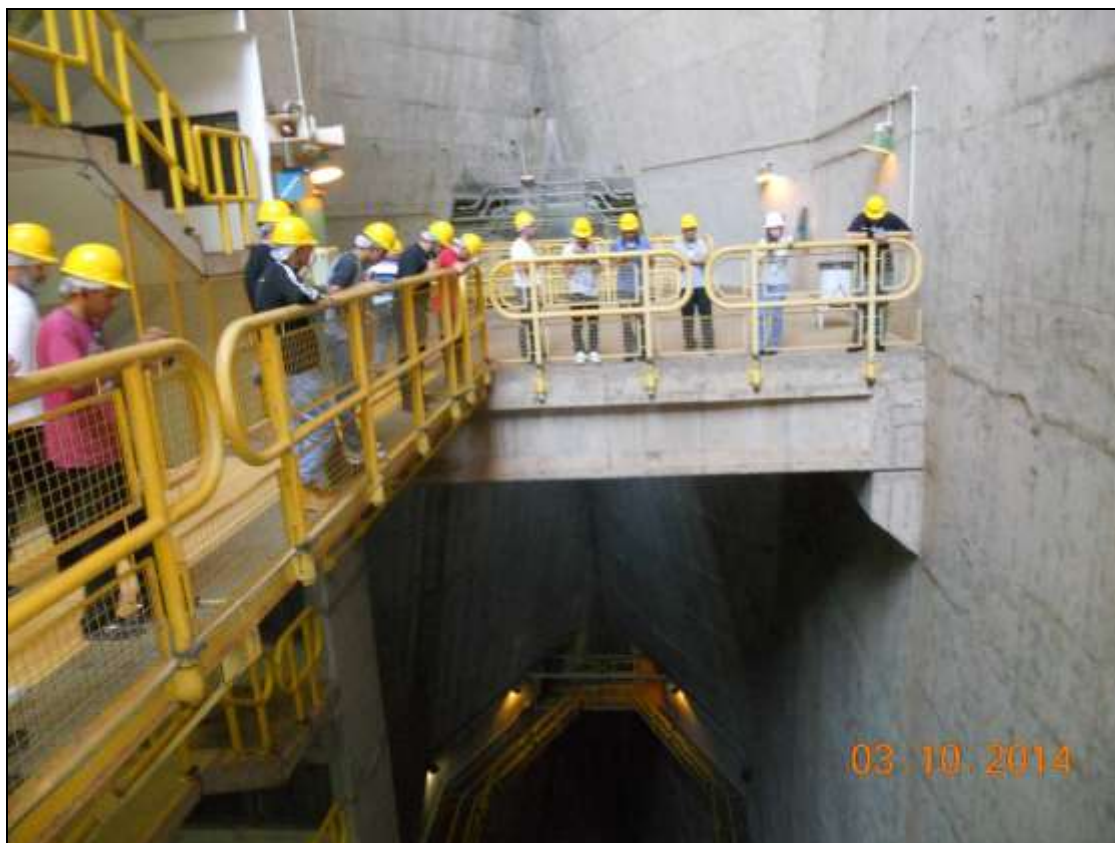
Figura 15 - Parte da estrutura que sustenta a barragem e a tubulação das turbinas na USINA HIDRELÉTRICA DE ITAIPU. FONTE: Frizanco (2014).
