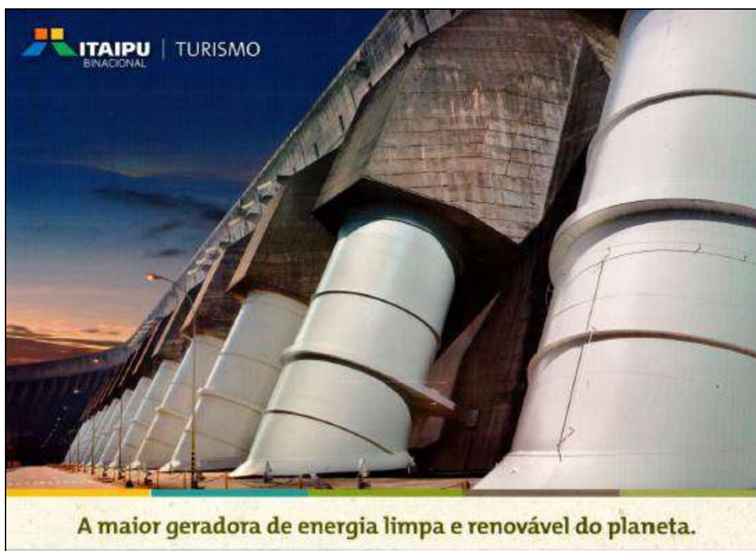
Figura 12 - Estrutura da tubulação na barragem central da USINA HIDRELÉTRICA DE ITAIPU. FONTE: Postal adquirido no Mirante Central (2014).
